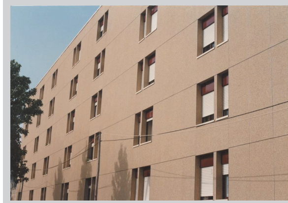
Fig. 5 – Aspecto geral de uma fachada reabilitada com revestimento independente descontínuo com interposição de um isolante térmico no espaço de ar
