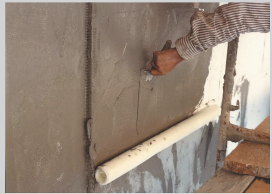
Fig. 7B – Aspecto da realização de um ETICS (revestimento delgado exterior)
