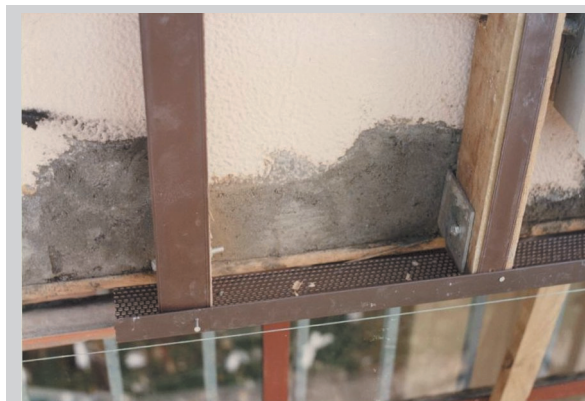
Fig. 6A – Pormenor da solução de ventilação da solução anterior
