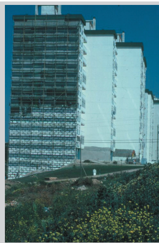
Fig. 9 – Aspecto geral de uma aplicação de ETICS numa empena
